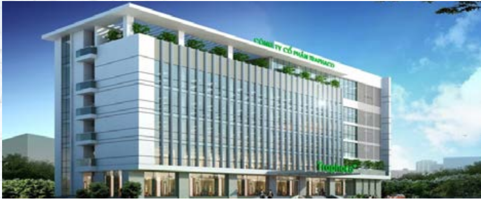
Nhà máy dược phẩm Traphaco/ Traphaco Factory ▼
